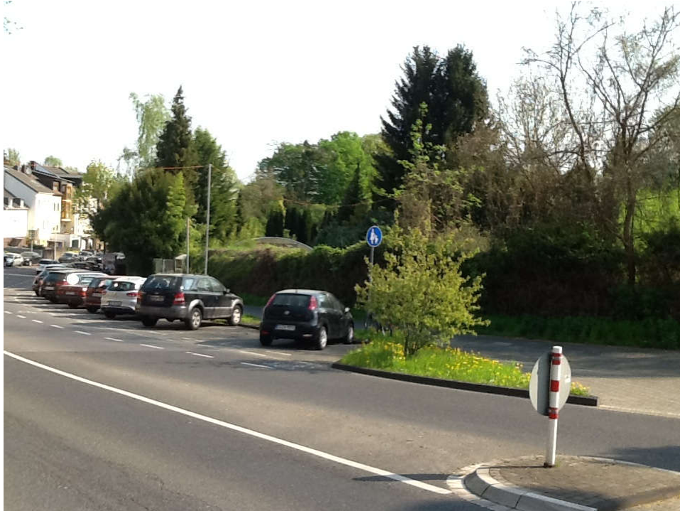
Der Engelsbach, der kanalisiert unter dem Fussweg verläuft, soll ein natürliches Bachbett erhalten.
