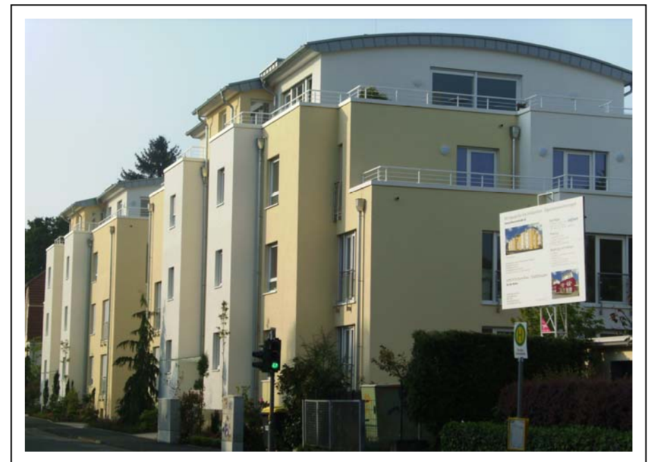
Deutschherrenstraße 58 u. 60 (Grundstück früher Haus-Nr.62), Blickrichtung Süden
